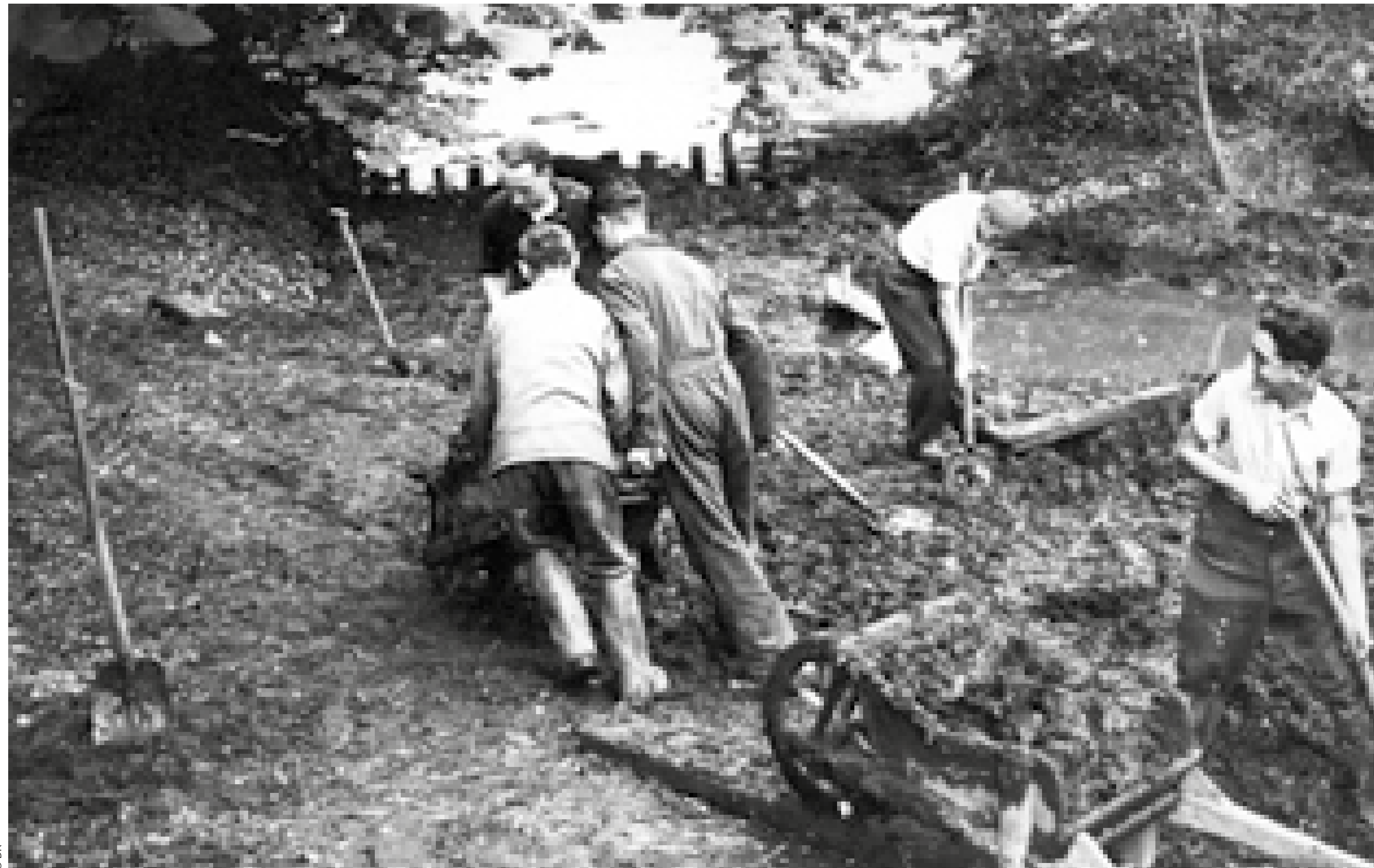
▼ Tewerkstelling van de Joden in België: Drooglegging van de moerassen rond Brussel. 1942.
