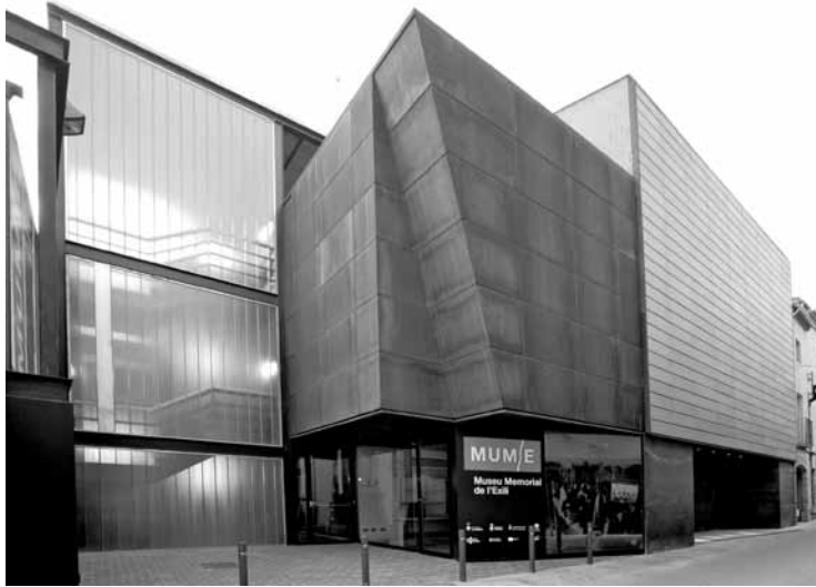
Détail du bâtiment du MUME, La Jonquera, Haut Empordan, Catalonia. © MUME.
