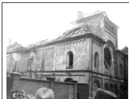
La synagogue de la Herzog Rudolf Strasse à Munich après son incendie. Bundesarchiv, Bild 146-1970-041-46 / Inconnu / CC-BY-SA 3.0 de
