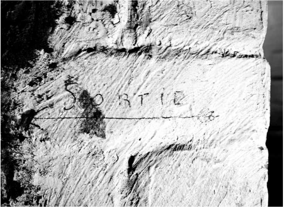
« Sortie » (flèche pointée vers l'intérieur de la cave)
