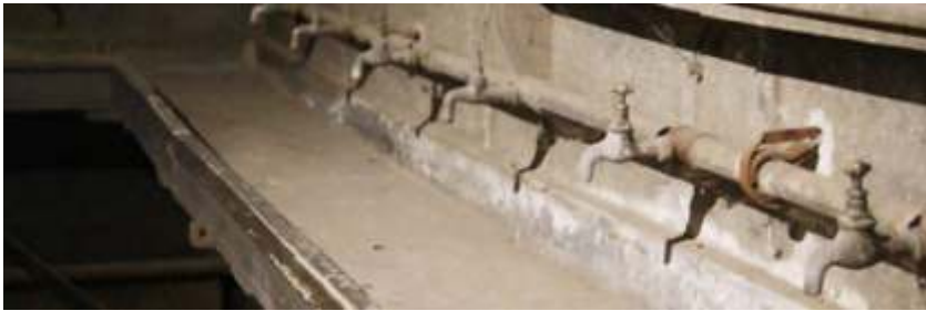
In de gang bevonden zich de lavabo's waaraan de gedetineerden zich op heel primitieve manier konden wassen. ↑
