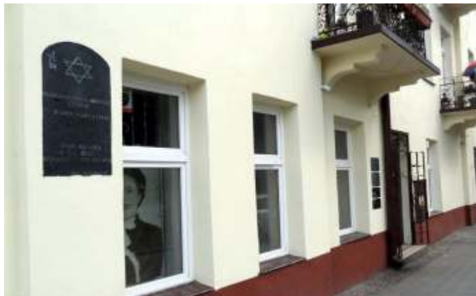
Het gebouw aan de Plantystraat herbergt een permanente tentoonstelling over de gebeurtenissen van 4 juli 1946 ▲
